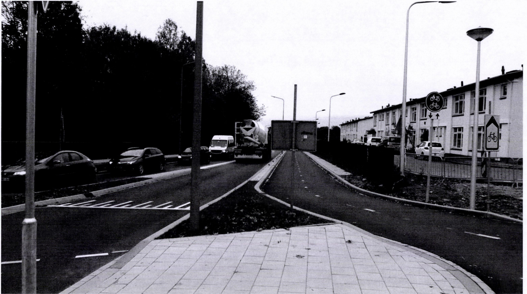
Fort-Willemweg. De Ravelijn rechts (monument). 13 huizen kijken uit op heipalen.
